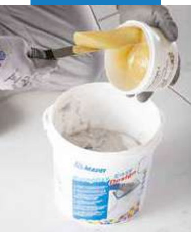
Nalejte tvrdidlo (zložka B) do zložky A
