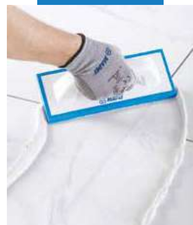
Lahké rozprestretie epoxidovej škárovacej malty
