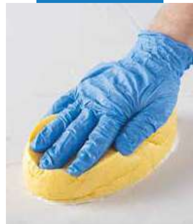
Ľahké čistenie povrchu pomocou celulózovej špongie
