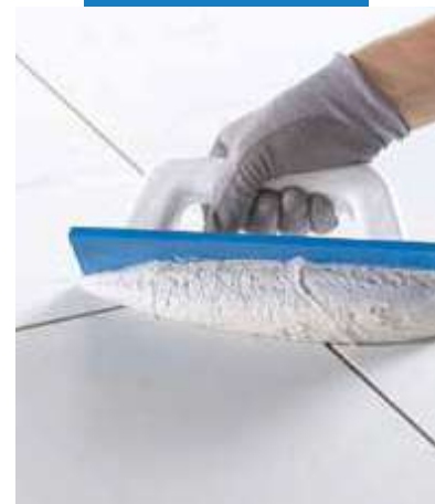
Aplikácia Kerapoxy Easy Design s gumenou stierkou MAPEI
