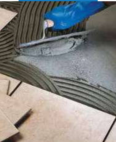
Inštalácia jeden krát vypaľovaných obkladových prvkov
