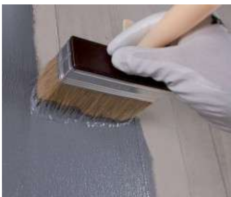
Aplikácia Eco Prim Grip Plus na betón so štetcom
