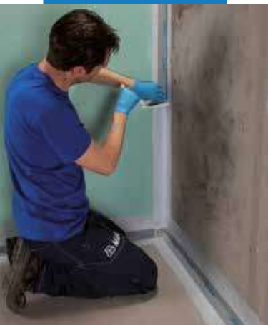
Inštalácia vel'koformátovej dlažby
